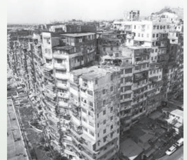
Kowloon city avant sa démolition en 1993 http://www.laboiteverte.fr/kowloon-walled-city/
